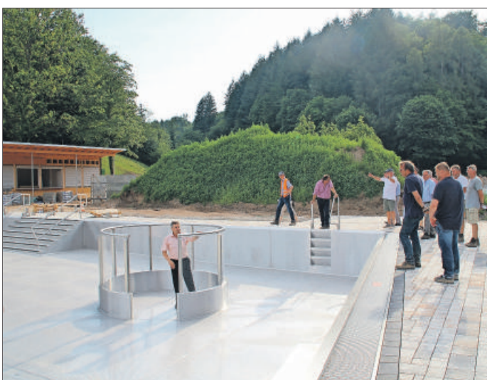
Oberbürgermeister Christof Florus nimmt die Becken in Augenschein.
