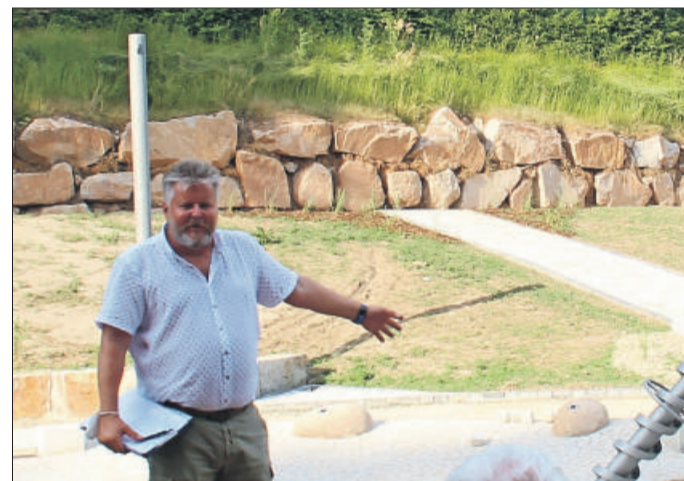
Waldseebad-Planer Hardy Gutmann erläutert den Gemeinderatsmitgliedern den Fortschritt der Arbeiten.
